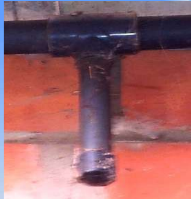
Sackloch nach Umbau
